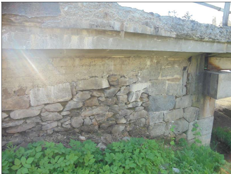
Degradace betonu horního líce římsy po pravé straně, rozevřená spára mezi betonem a ohrubníkem s uchycenou vegetací.
