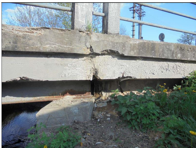
Oblast uložení krajního levého nosníku na OP1.
