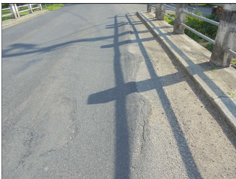
Plošně deformovaná vozovka na mostě, hrby a prohlubně.
