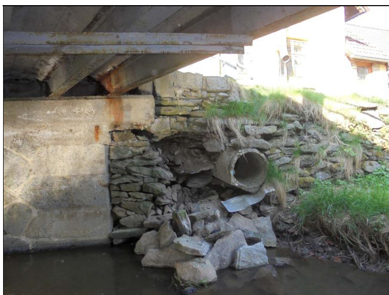
Rozpad zdiva nábrežní zídky u opěry 2 vpravo, v zídce je vyústěna roura kanalizace.
