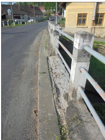
Degradace betonu horního líce římsy po pravé straně, rozevřená spára mezi betonem a ohrubníkem s uchycenou vegetací.
